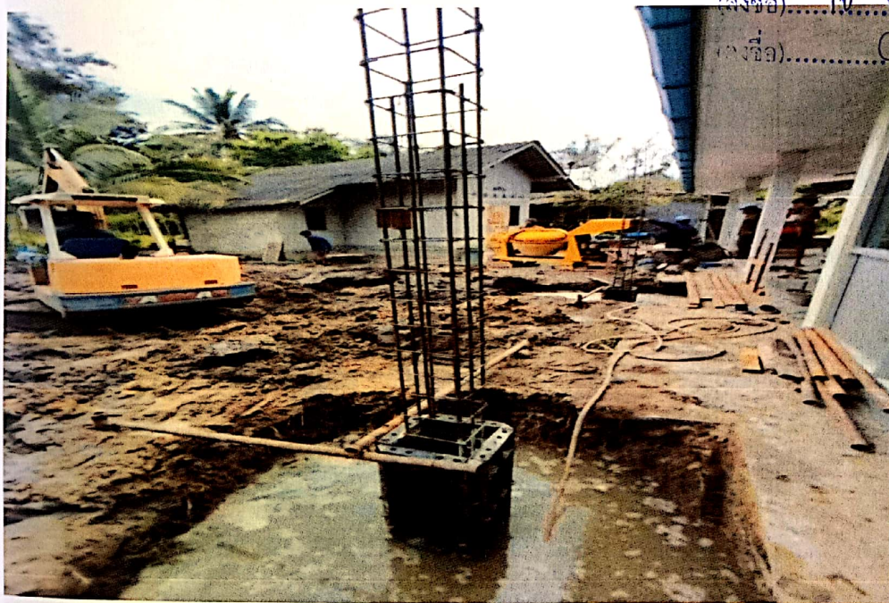
ผูกเหล็กตะแกรงและเทคอนกรีตเสาต่อหม้อ
